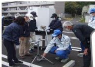
組立式給水タンク設置状況
