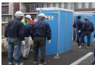
マンホールトイレ設置状況
