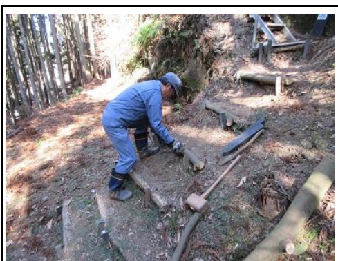
階段補修：土留め材の交換・設置
