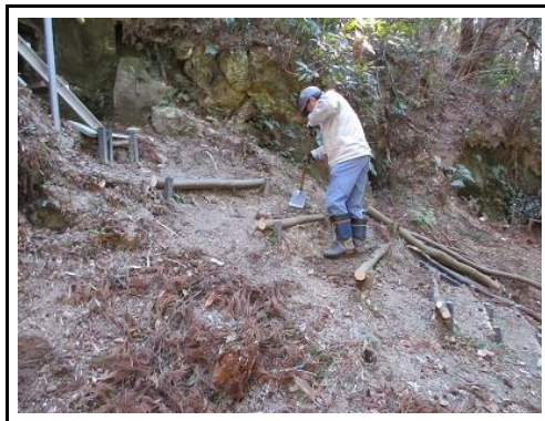
階段補修：21号墓前階段、土盛り、水平出し
