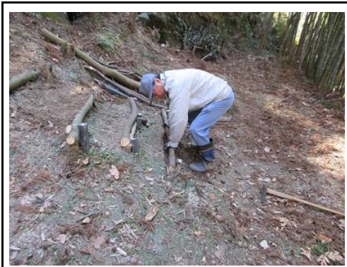
階段補修：21号墓前階段、土留め材の交換
