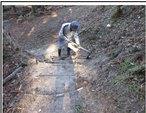
階段補修：アプローチ階段、土盛り、水平出し
