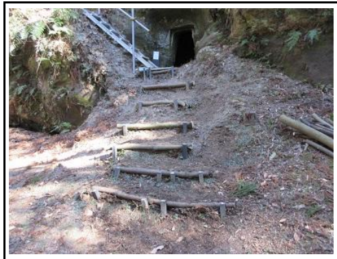
階段補修：21号墓前階段、6段補修完了
