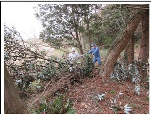
雑木類の伐採：水路跡の脇
