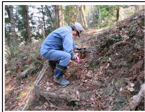
階段補修：硬い丸枝に交換
