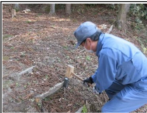
階段補修：プラスチック角杭に交換
