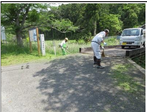
草刈整備：案内板・道標廻り
