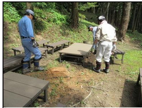
1台目の設置完了
