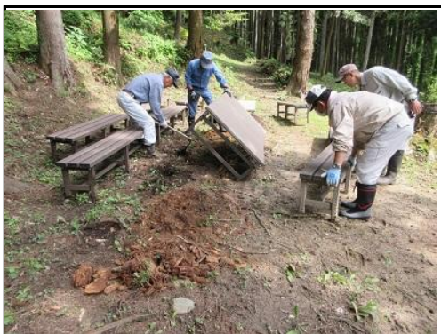
2台目の設置場所の整地
