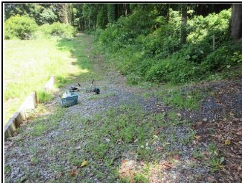
草刈整備：杉林側の市道脇、入口部
