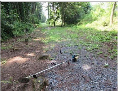
草刈整備：市道砂利敷部分
