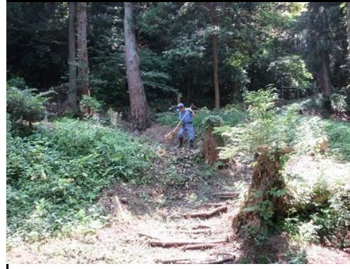
アプローチ階段の整備：杉葉類の除去
