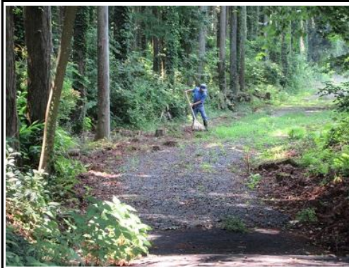
市道の整備：砂利敷部分、杉葉類の除去
