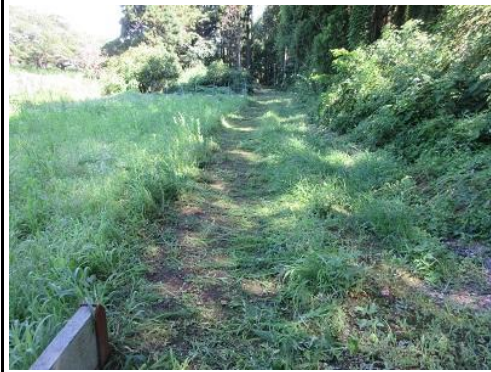
草刈整備：杉林沿いの市道、草の伸びが早い
