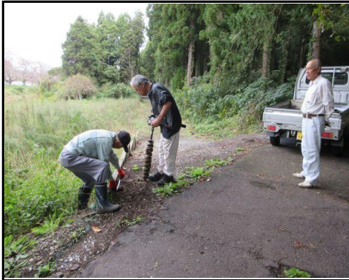
案内図掲示看板設置：設置穴位置の計測
