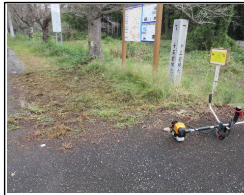
草刈整備：木の橋前の案内板周り
