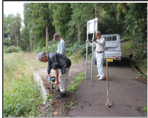
案内図掲示看板設置：設置穴掘り
