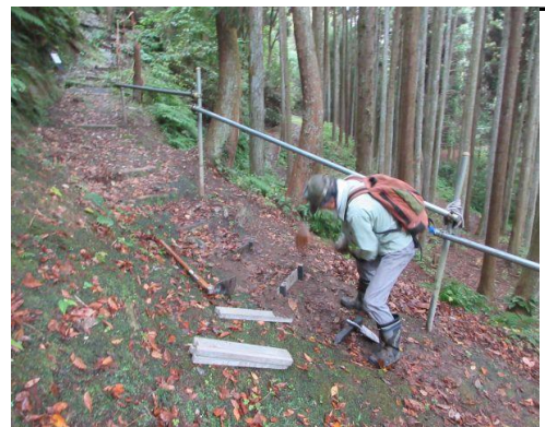
2号墓前階段の補修
