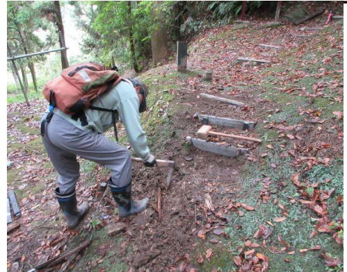
1号墓前階段の補修
