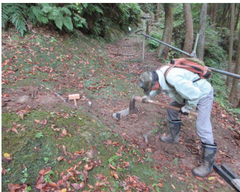
1号墓前階段の補修
