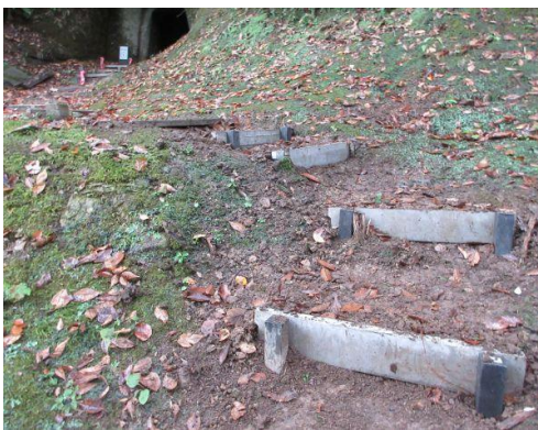
1号墓前階段補修：予定の5段、完了
