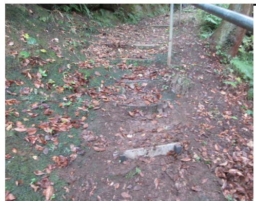
2号墓前階段補修：1段完了、残6段
