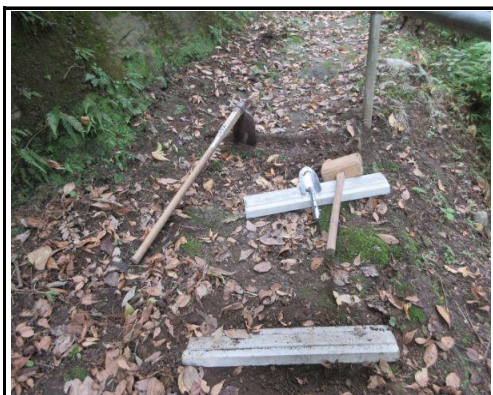
2号墓前階段の補修：6段目の位置決め
