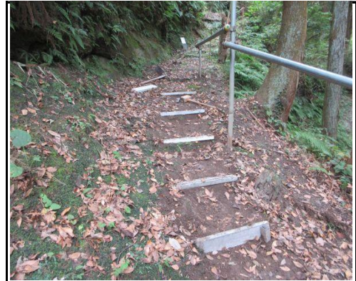
2号墓前階段の補修：5段まで完了
