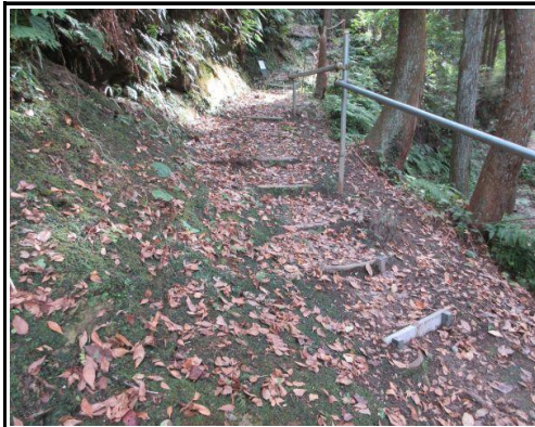
2号墓前階段の補修：本日予定の前段の6段
