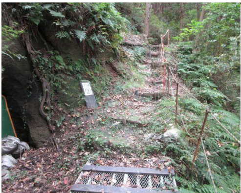
2号墓前階段補修：次回予定の14号墓への階段6段
