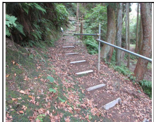
2号墓前階段の補修：予定の6段完了
