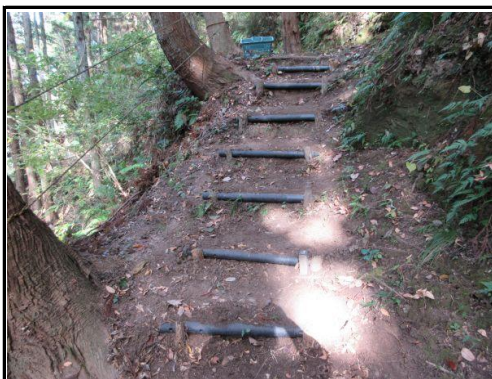
階段補修完了：16号墓から17号墓への階段
