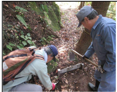
階段補修：17号墓前の階段1段
