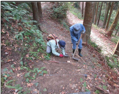
階段補修：16号墓から17号墓への階段7段目
