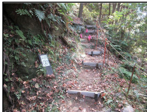
階段補修完了：2号墓前、14号墓への階段
