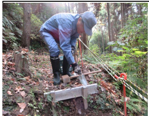
階段補修：2号墓前、14号墓への階段6段目
